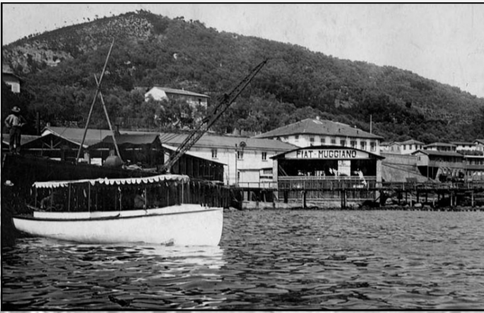
Cantiere navale "Fiat Muggiano" 1906
